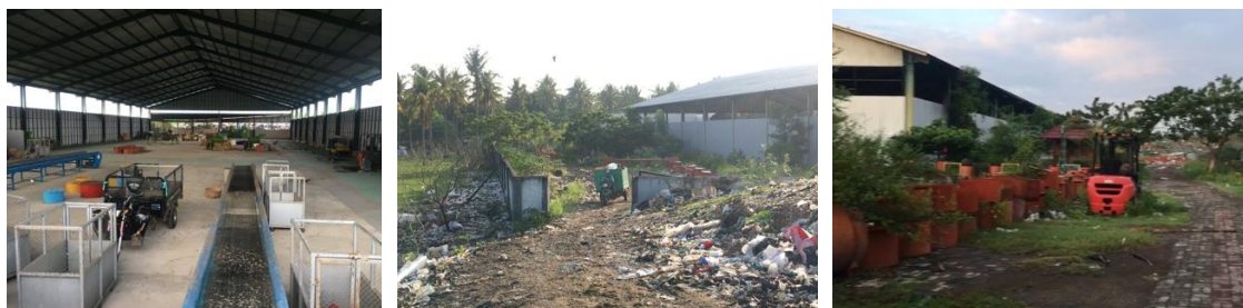
Gambar 1. Kondisi Lingkungan TPST
